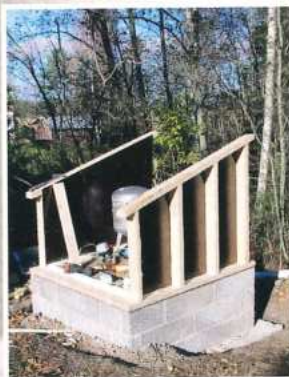
Kaivokopin runko rakennettiin valmiiksi elementti kerrallaan ja siirrettiin paikalleen.
