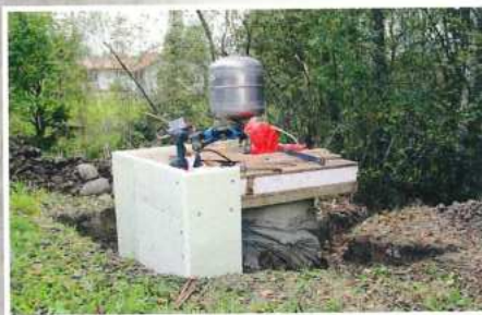
Aluksi kaivettiin oja sitkeään saveen. Betoni-renkaat saivat myös eristesuojan.
