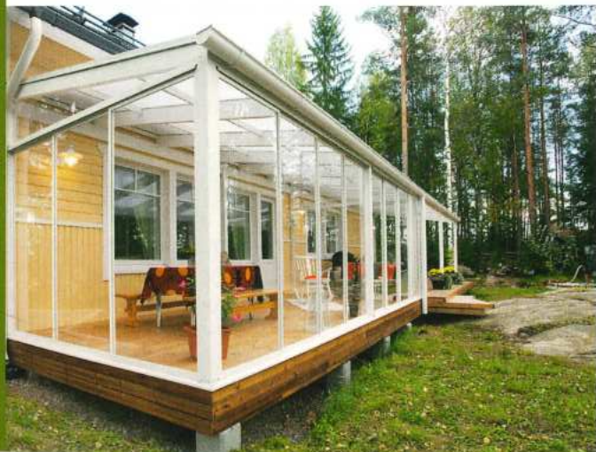
● Näyttävässä terassilasituksessa on kattona 16 mm:n paksui- nen maidonvalkoinen PC-monikerroslevy. Kuva: Keraplast.
