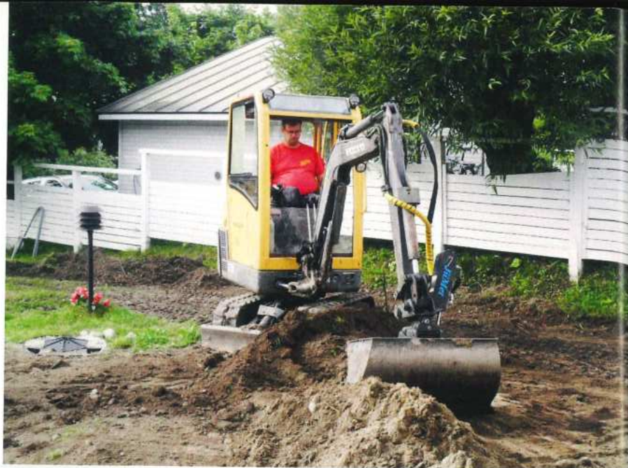
Petri Pylvänäinen salaojitusta tekemässä. Kuva Heikki Huttunen.
